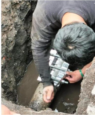
REPARACION DE FUGA DE AGUA
